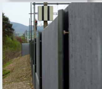
Fertig montierte LSW mit GFRP-Lärmschutzwand-Pfosten
