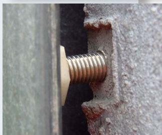
Klemmschraube im versetzten Zustand
