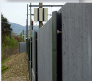
Fertig montierte LSW mit GFRP-Lärmschutzwand-Pfosten
